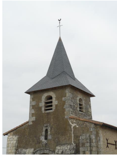
Le clocher rénové
