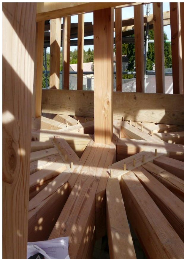
Charpente durant les travaux
