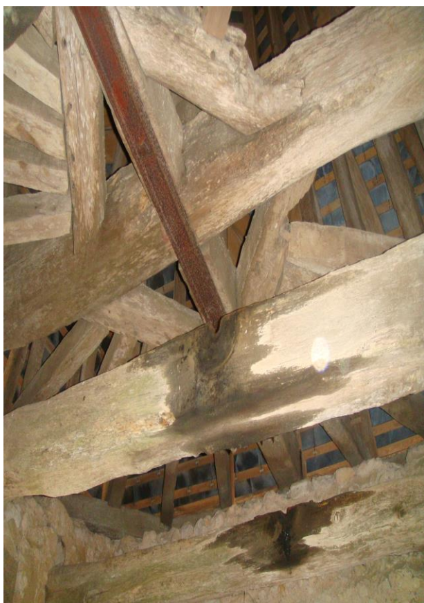
Charpente avant travaux
